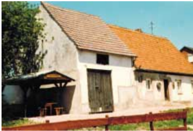
Unsere neue Hütte in Heubühl, 1981 Vollendung des 1. Bauabschnittes
