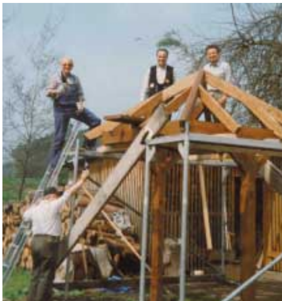
Richtfest am Saukopfpavillon
